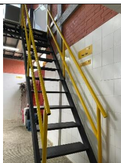
Barandas escalera interna
